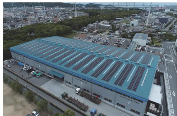
図2 製品倉庫屋上の太陽光発電設備<sup>2)</sup>
