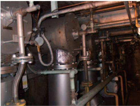
図7 大形圧延加熱炉 下部帯バーナー
