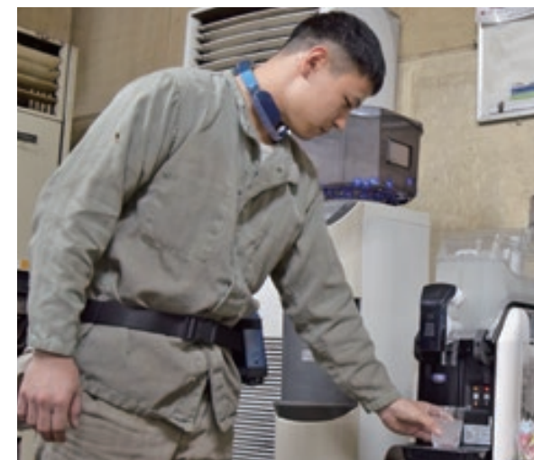
アイススラリー製造機を設置
