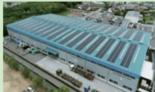
製品倉庫屋上の太陽光発電設備
