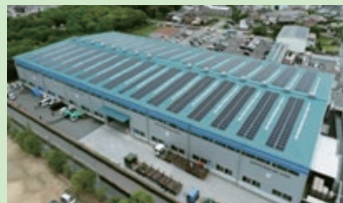
製品倉庫屋上の太陽光発電設備
