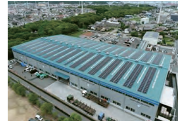
製品倉庫屋上の太陽光発電設備
