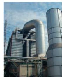
電気炉集塵設備
