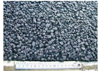
アスファルト骨材を使用した排水性舗装事例
