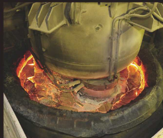
RH真空脱ガス設備
