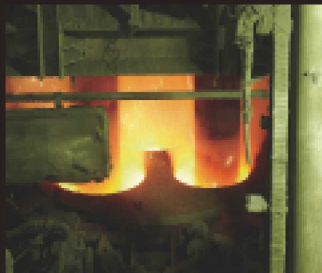
取鋼精錬設備 [LF]
