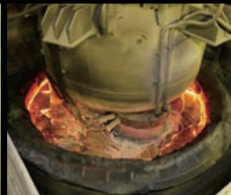
RH真空脱ガス設備
