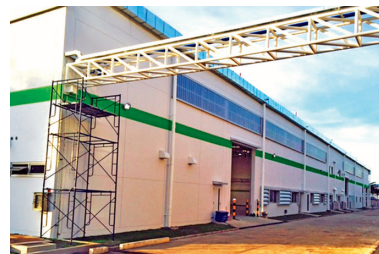
Siam Sanyo Special Steel Product Co., Ltd. の工場建屋
