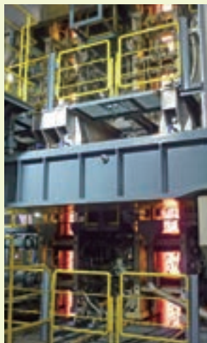
60トン連続鋳造設備
