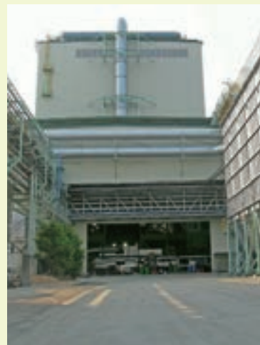
設備建屋外観
