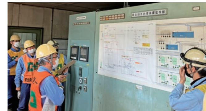
排水処理施設のパトロール
