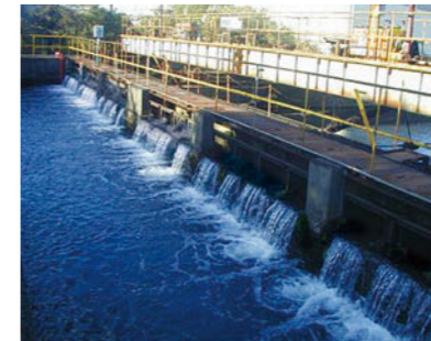
排水処理施設
