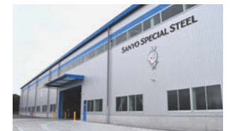
新製品倉庫の外観
