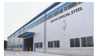
新製品倉庫の外観
