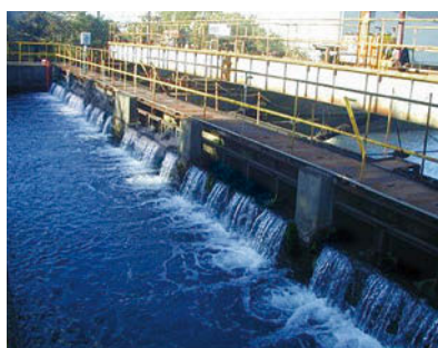
排水処理施設
