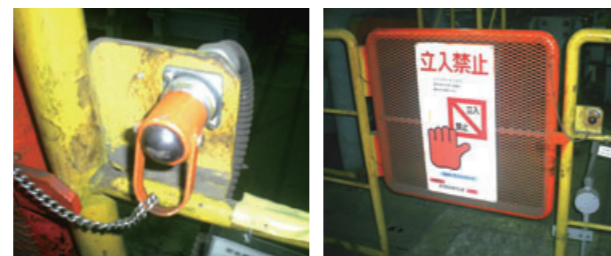
安全装置(左)・安全柵(右)の設置
