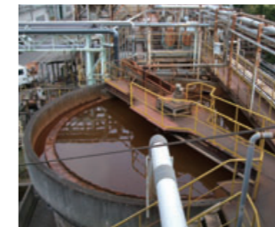
排水処理施設
