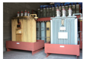
保管倉庫にて、PCB廃棄物を保管・管理
