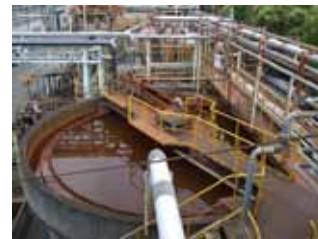
排水処理施設
