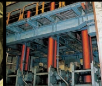
連続鋳造設備
