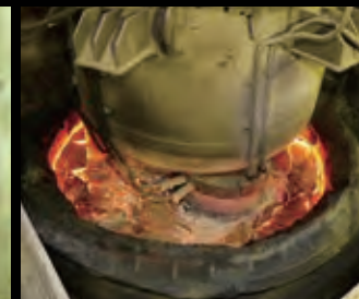
RH真空脱ガス設備
